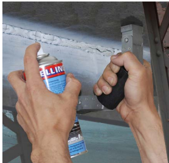
Проверка сварных соединений моста с помощью черной суспензии BW 333 и белой фоновой краски NR 104 A
